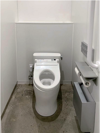
女性トイレ 大便器ブース
