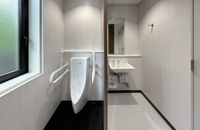
1F 男性トイレ 小便器・洗面コーナー
