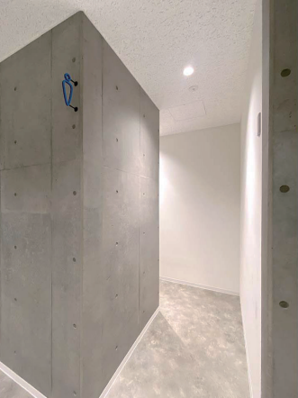
3F トイレ・更衣室 入口
