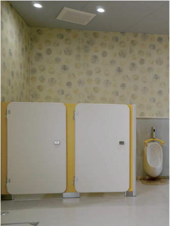
キッズトイレ 幼児用大便器ブース
