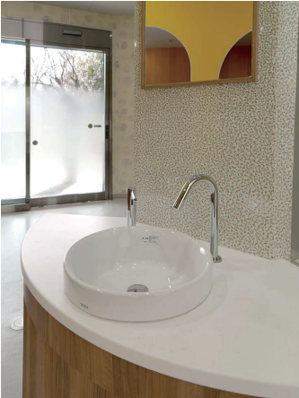
キッズトイレ 洗面器コーナー
