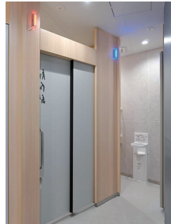
男性トイレ 大便器コーナー
