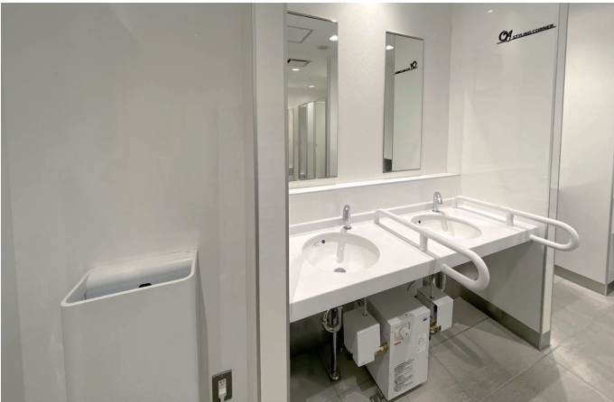
女性トイレ 洗面コーナー
