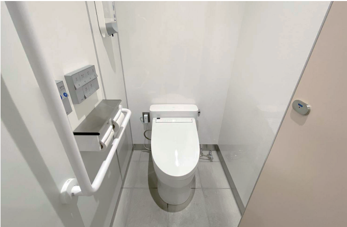
女性トイレ 大便器ブース
