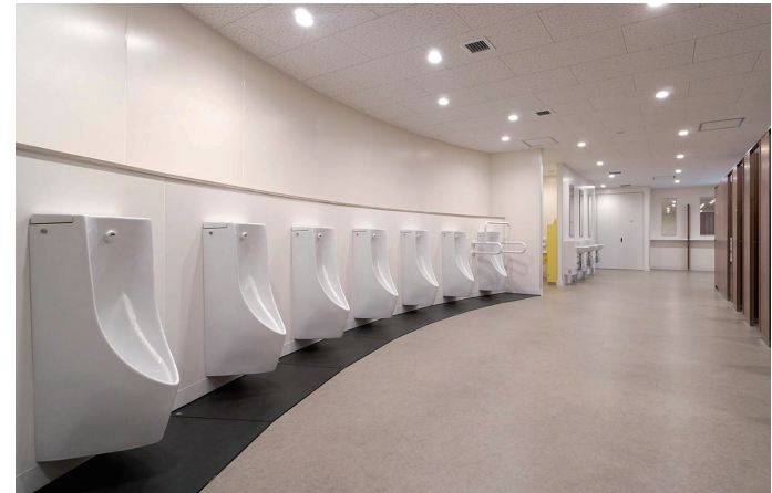
男性トイレ全体
