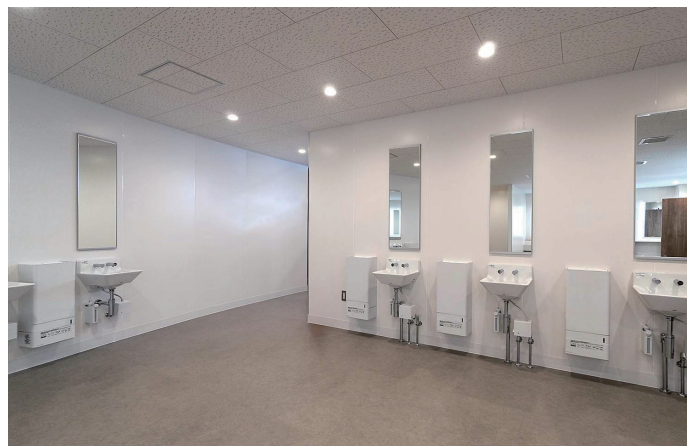
女性トイレ 洗面コーナー
