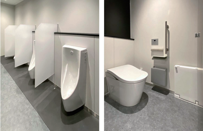
1F 男性トイレ 小便器コーナー・ 大便器ブース
