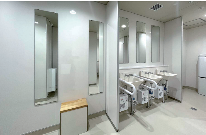
女性トイレ 洗面・ スタイリングコーナー
