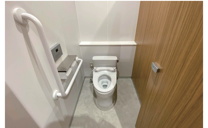
2F 女子トイレ 大便器ブース
