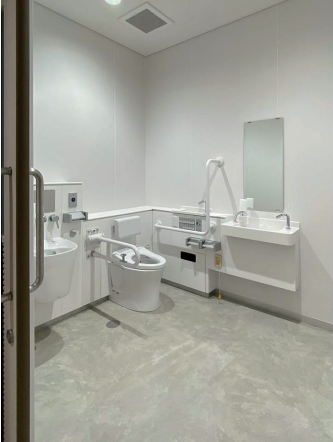
1F 保健室 水まわり
