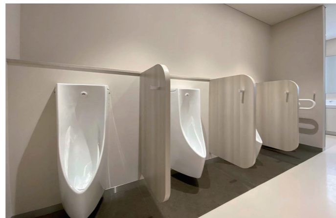
B1Fラウンジ横 男性トイレ 小便器コーナー
